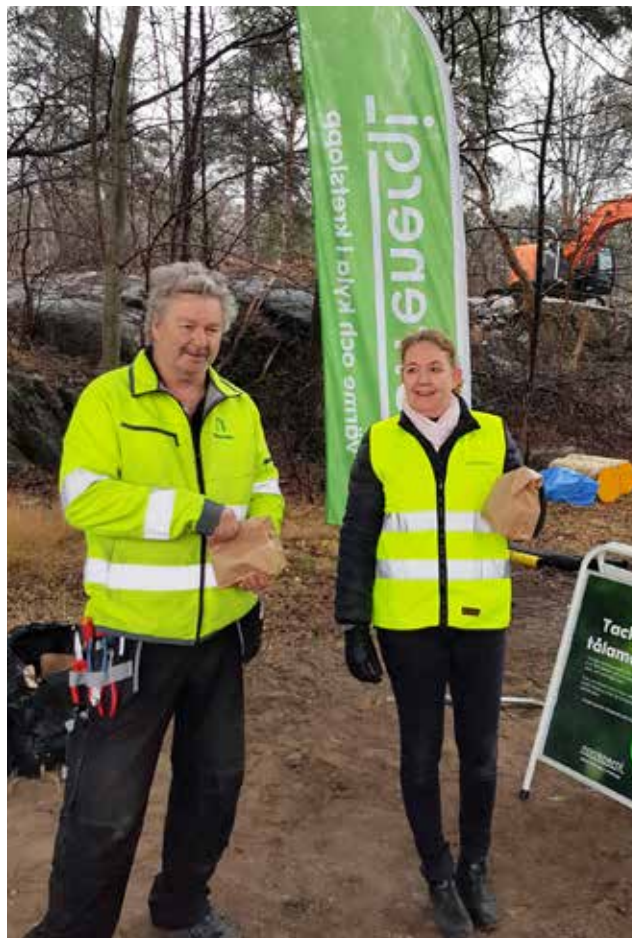
Utbyggnaden av kyla till Bromma gjorde att vi behövde stänga av gång- och cykelvägen vid Solna strand. I februari kunde vi öppna den igen och passade på att dela ut frukostpåsar som tack för tålamodet.
