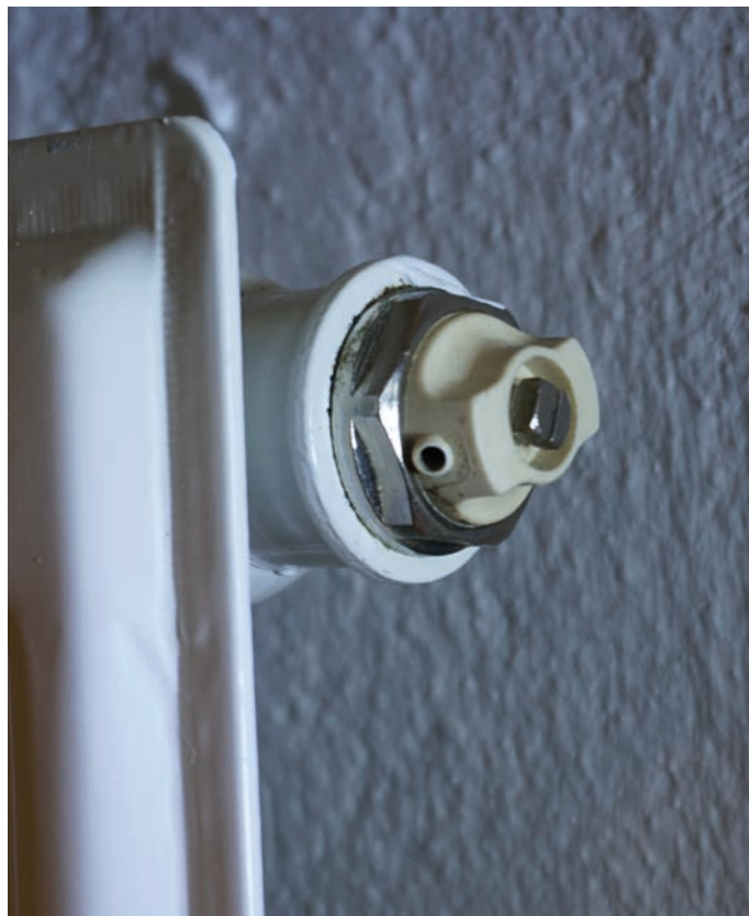
Nippeln på ditt element kan se ut så här.
